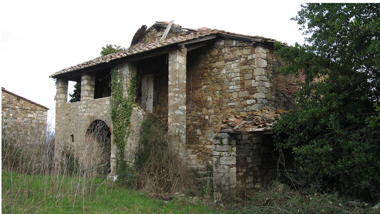
Foto di edificio esistente nel borgo di Elci, estrapolata dalla schedatura del Patrimonio Edilizio Esistente del RU di Radicondoli
