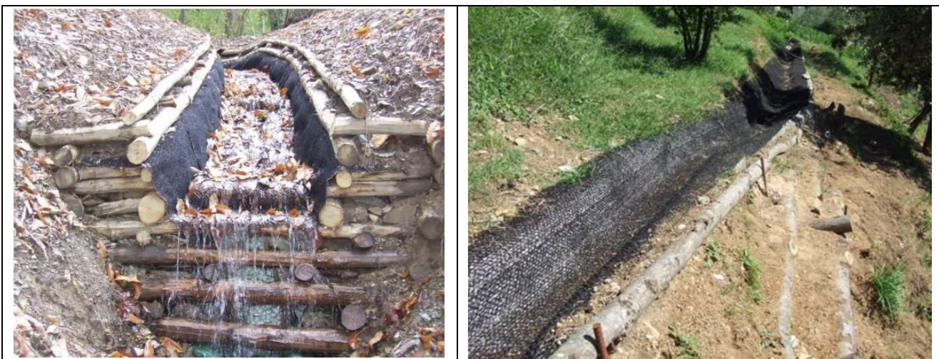
IMMAGINI DI INTERVENTI ESEGUITI CON GEOCOMPOSITO SENZA RINTERRO SUPERFICIALE
