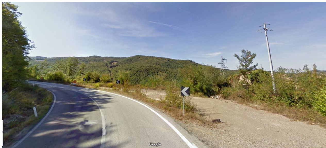
VISTA DALLA S.P 35 VERSO SUDOVEST
