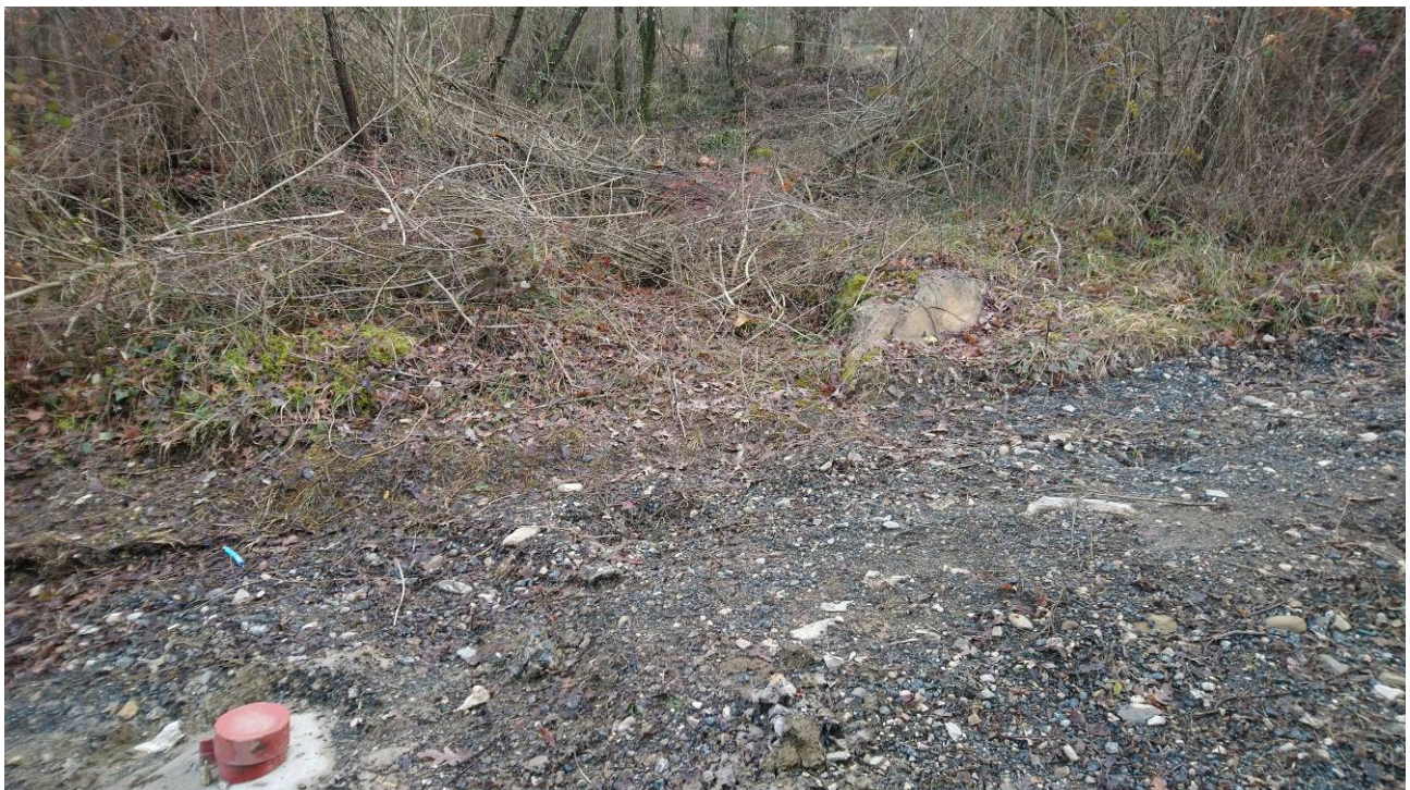
PARTICOLARE DEL FONDO CARRABILE DELLA PISTA DI SERVIZIO A VALLE DELLA S.P. 35
