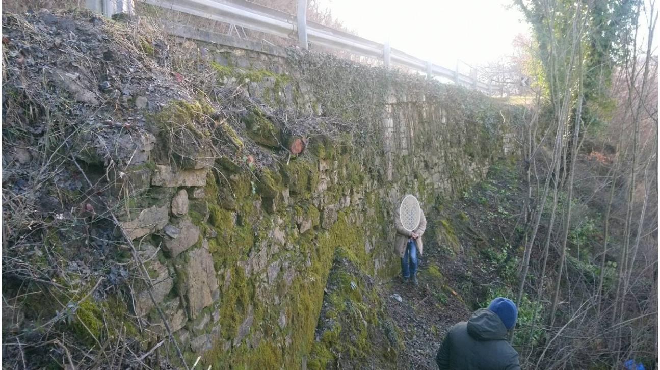
VISTA GENERALE DEL MURO DAL LA TO DI VALLE
